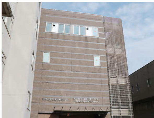
高次救命災害治療センター
